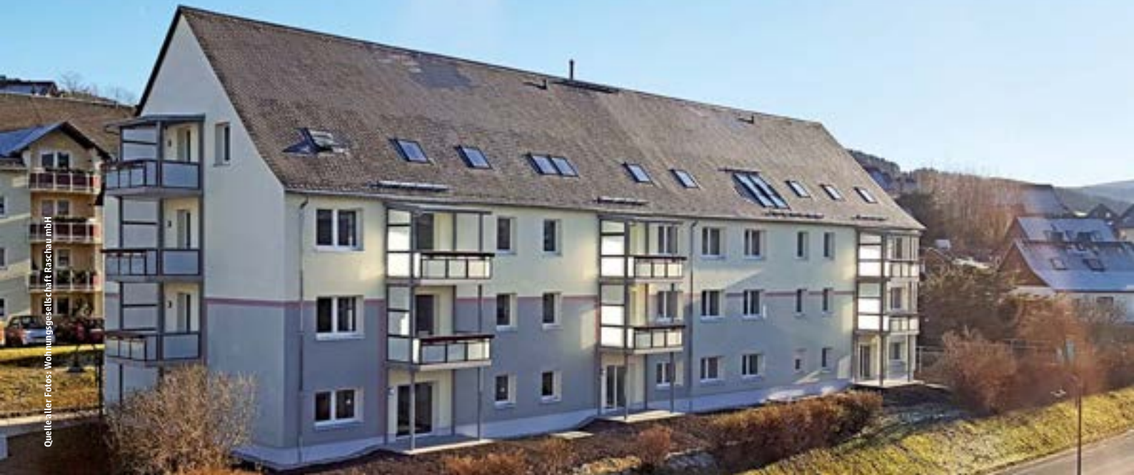
Nach einem Umbau verfügt das ehemalige Ledigenwohnheim über 18 moderne, schwellenfrei zugängliche und mit AAL-Technik ausgestattete Wohnungen
