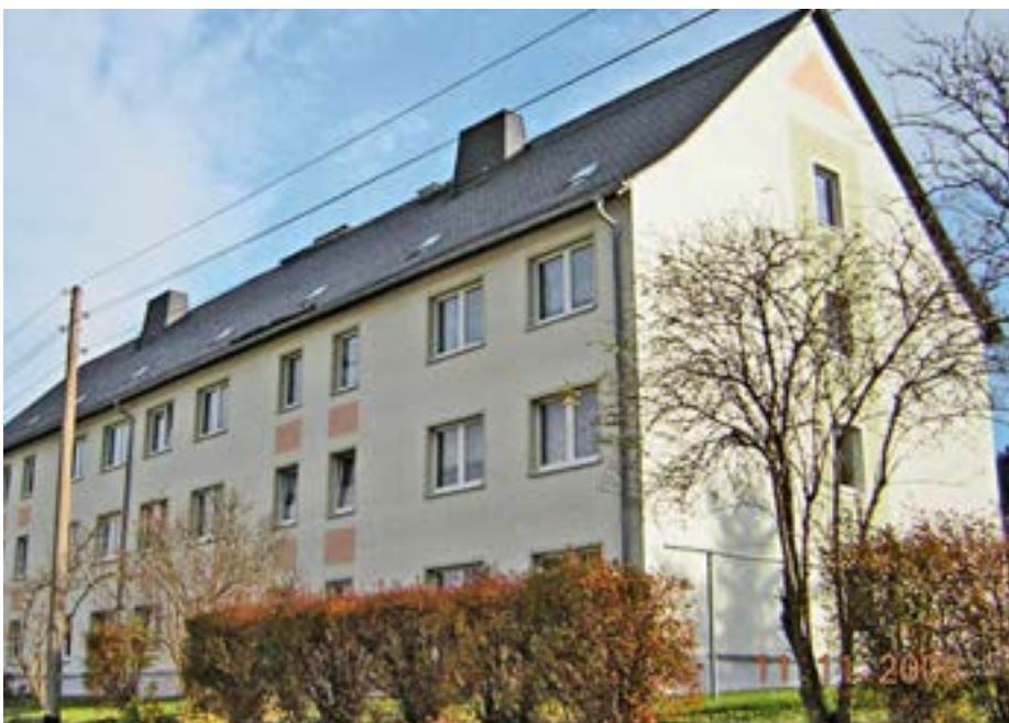
Das 1971 errichtete Wohnhaus vor dem Umbau
